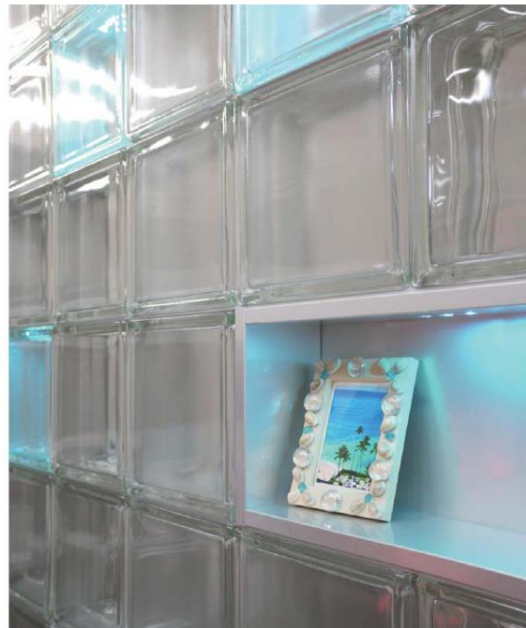
شكل رقم (9) يوضح صورة لحائط من الطوب الزجاجي المركب بواسطة قطاعات الألومنيوم
