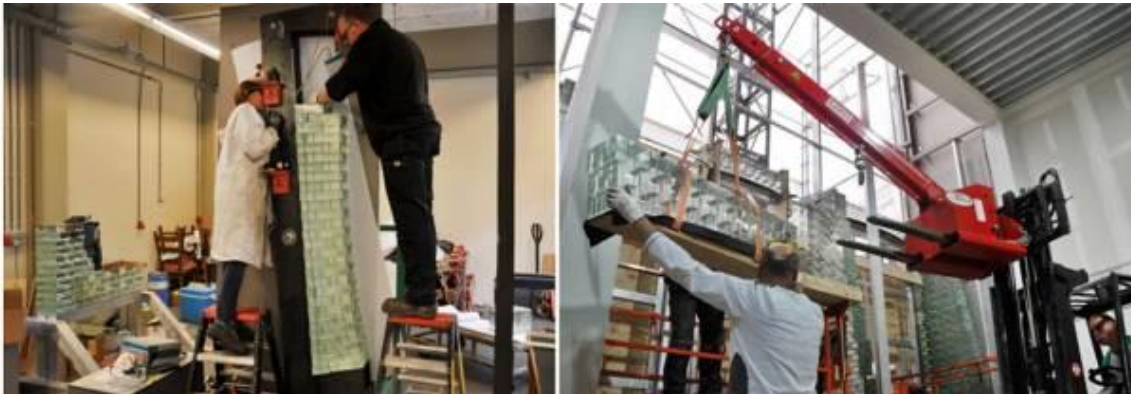
شكل رقم (24) يوضح طريقة النقل والتجهيز للتجميع والتركيب في واجهة المبنى
