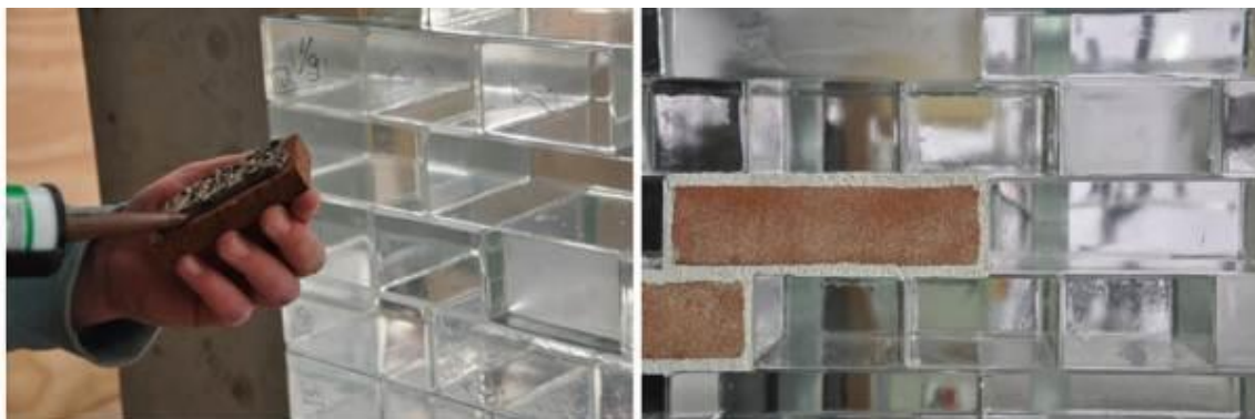
شكل رقم (25) يوضح طريقة وضع القرميد الحرارى السيراميكى متراصاً مع الطوب الزجاجى 7
