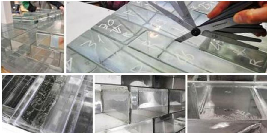
شكل رقم (20) يوضح كيفية ازالة زيادة الربط واللسق والتنظيف وتحديد البلاطات
