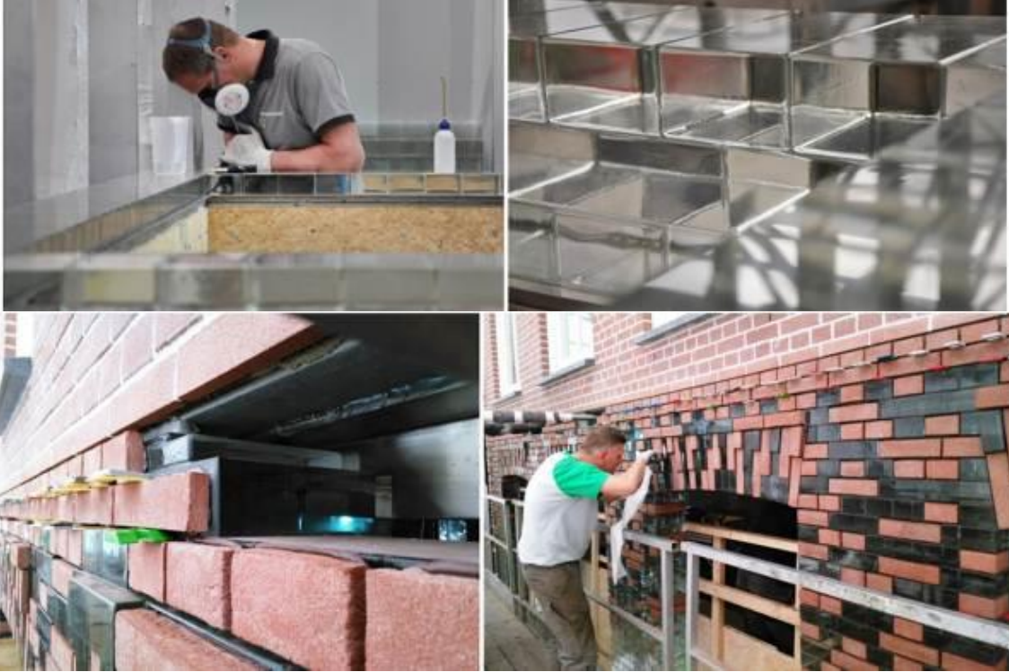
شكل (23) يوضح مراحل التركيب في الواجهة للمبنى
