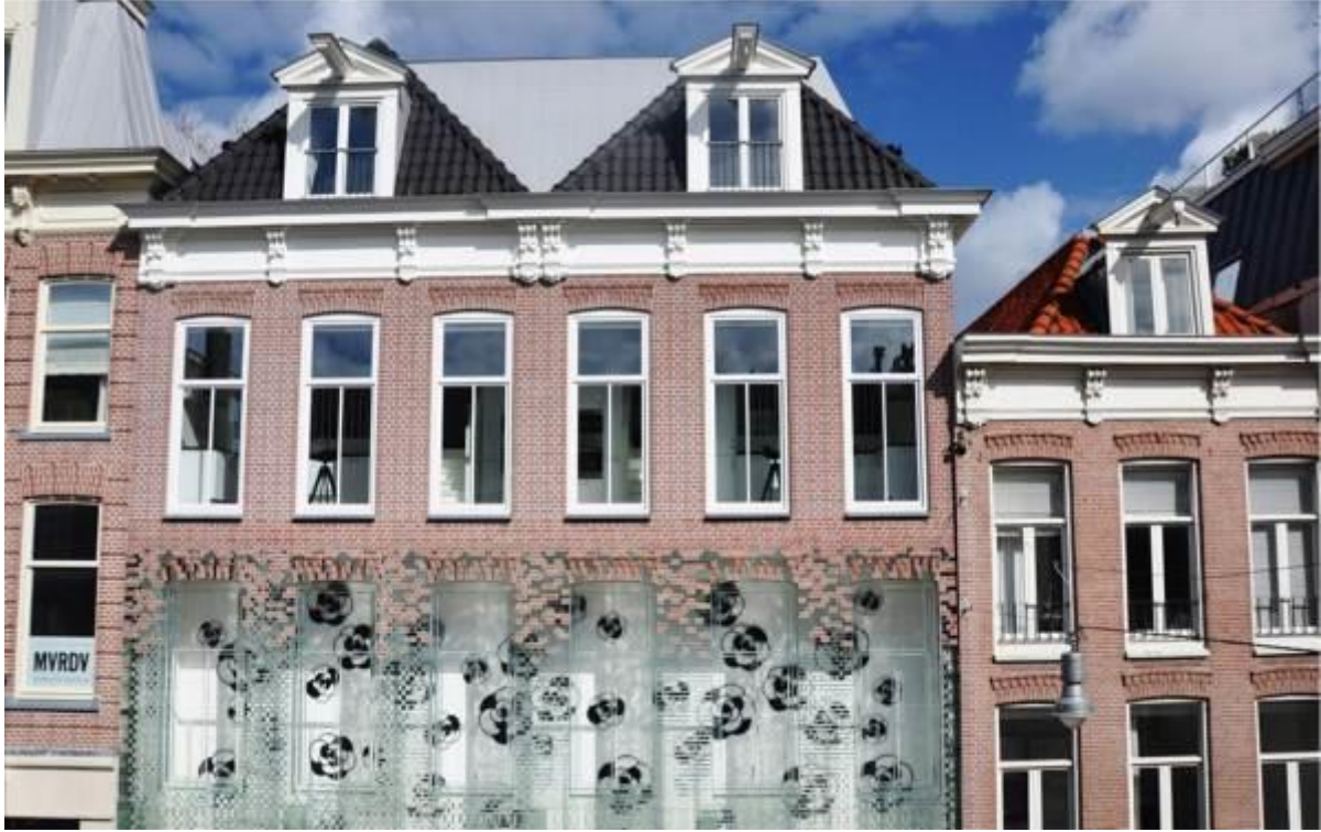
شكل رقم (26) يوضح صورة المبنى بعد التركيب النهائى للجدار المكون من الطوب الزجاجى
